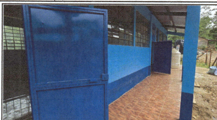
Foto 2: Vista panoramica del establecimiento despues de finalizar los diferentes procesos de mantenimiento
