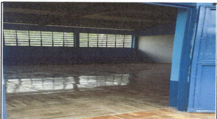
Foto 3: Se evidencia en la imagen la finalizacion de instalacion de piso, aula numero I
