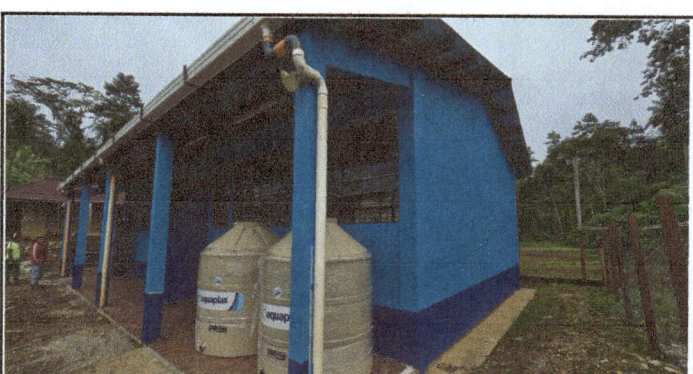
Foto 6: se observa la finalizacion de la instalacion del canales de metal, asi mismo el notorio la finalizacion de la aplicacion de pintura del centro estudiantil
